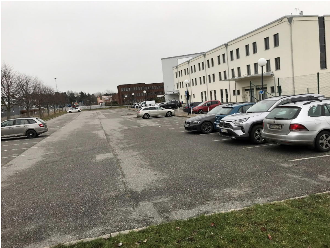
Figur 2. Parkeringsplats och byggnad, från väster.
